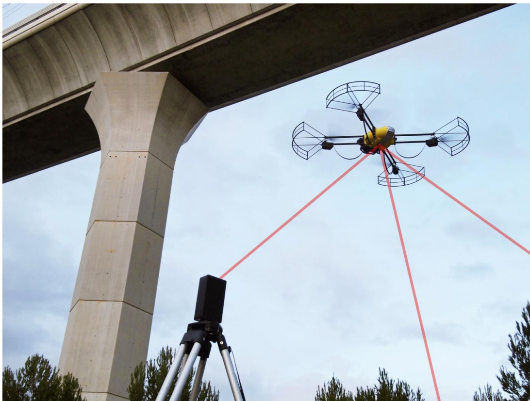
Le drone U130 NOVADEM guidé par la technologie LPS réalise une inspection automatique d'ouvrage
